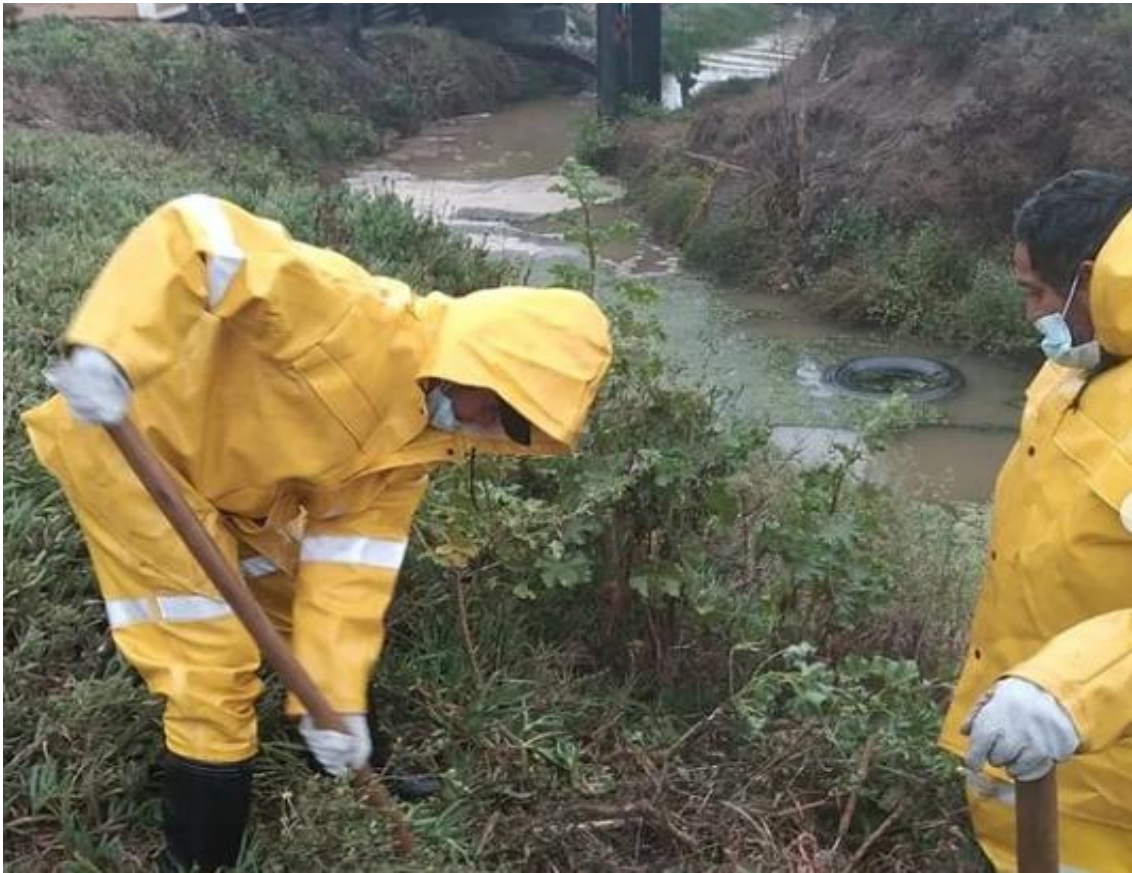
Figura 21: Personal de la Dirección de Operaciones y Emergencias realizando trabajos de despeje y limpieza. Fuente: Instagram Municipalidad de Pichilemu (2022).
